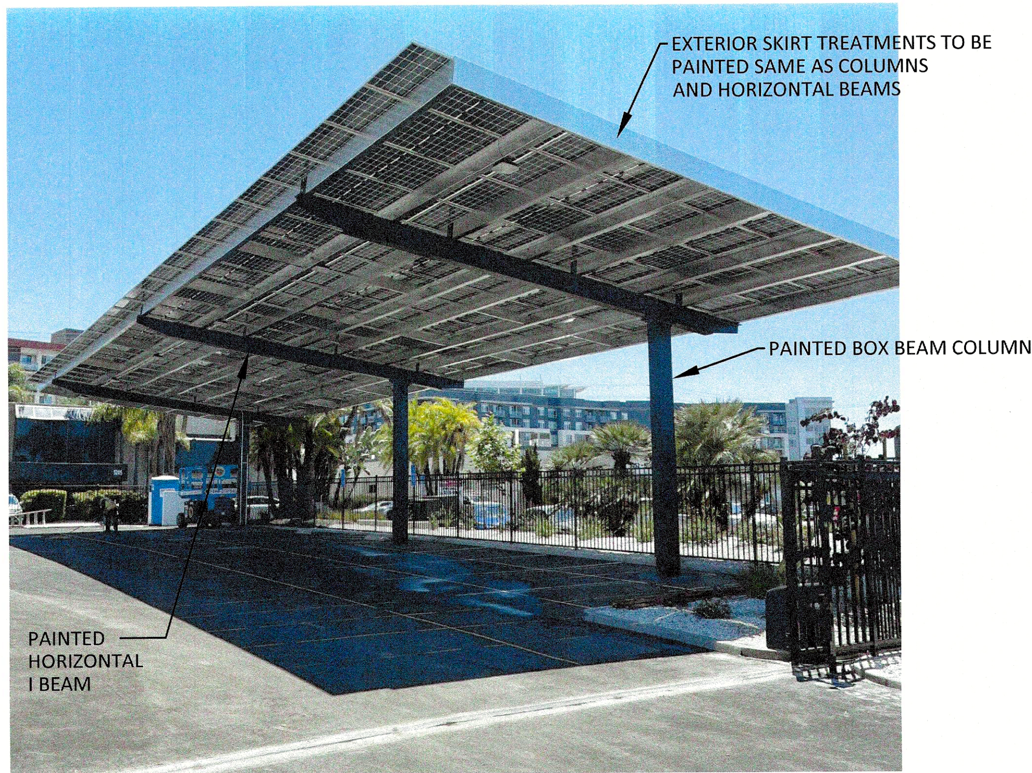
TYPICAL SOLAR CARPORT STRUCTURAL RENDERING SCALE: N.T.S.
